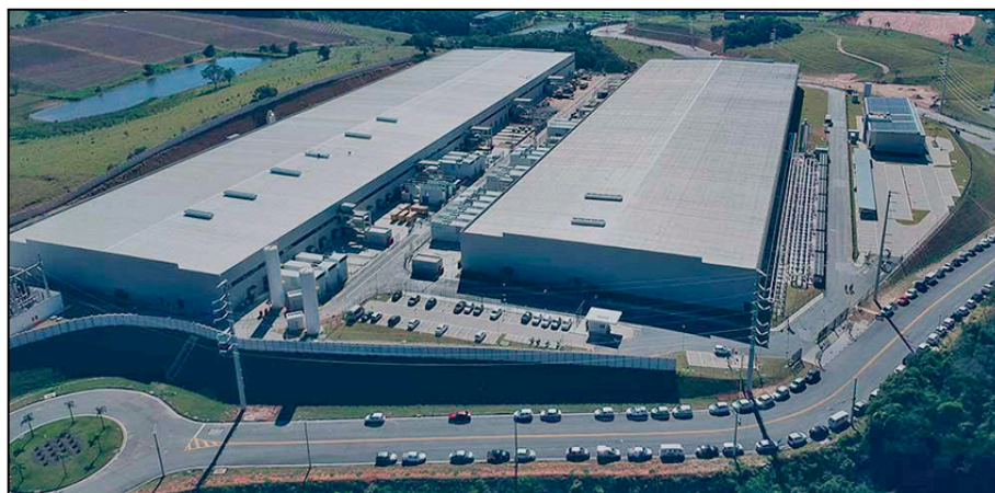
Figura 7. Maior Data Center da América Latina em Vinhedo - São Paulo.
