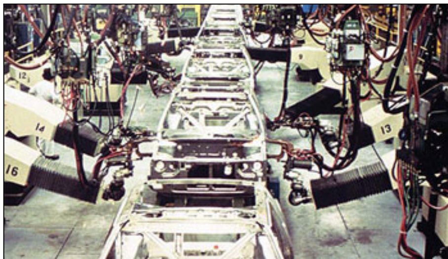
Figura 6. Em 1969, na fábrica da General Motors , robôs de solda ponto: Unimate .
